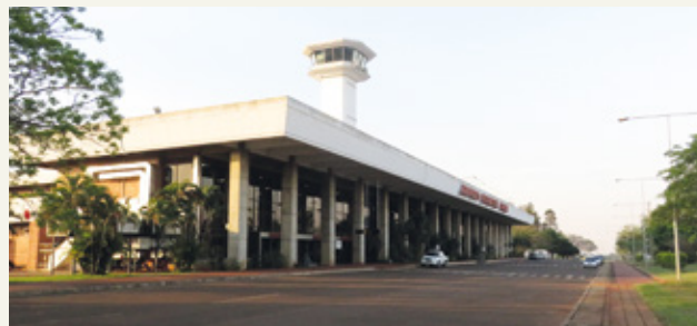
El Aeropuerto Internacional Guaraní, en Alto Paraná, fue construido con la cooperación financiera de Japón.
