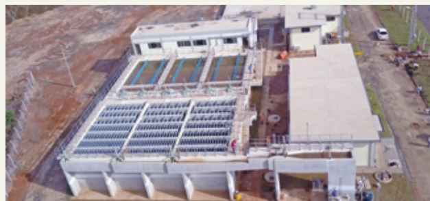
Planta de producción de agua en Coronel Oviedo. Forma parte del Proyecto de Mejoramiento del Sistema de Agua Potable de la ciudad.
