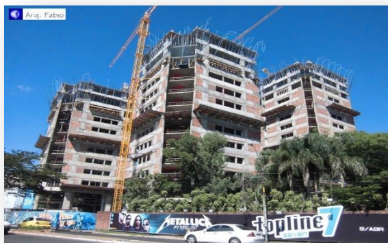
(アスンシオン市内に建設中のオフィスビル)
