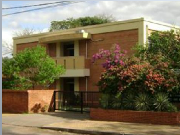
無償資金協力によって整備された印刷・コンピューター棟
